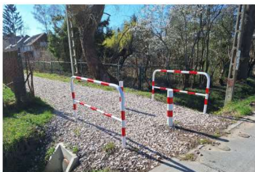
Remont ciągu pieszego w sołectwie Słomczyn
