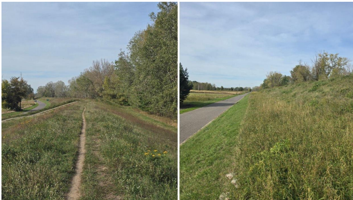
Fot. 1. Wał przeciwpowodziowy na granicy sołectw Kępa Oborska i Okrzeska (fot. D. Gariat).
